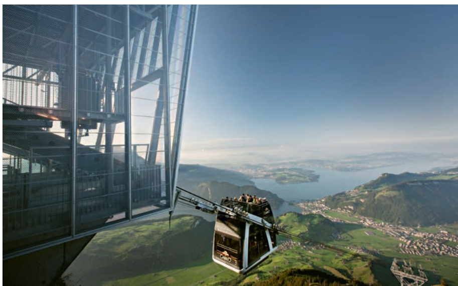
CabriO-Luftseilbahn, Stanserhorn, Vierwaldstättersee Region
